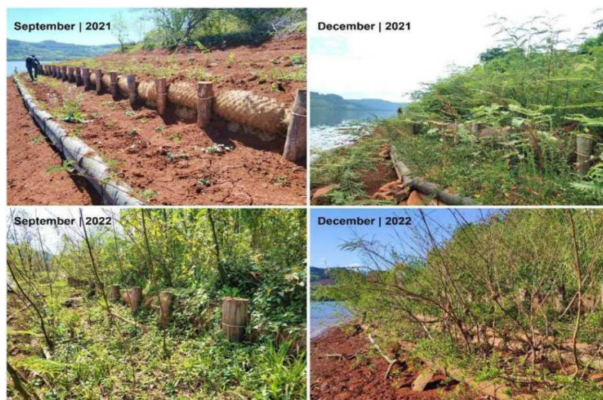
Figura 3.6: Evolución de técnicas de bioingeniería consistente en biorretenedores de fibra de coco vegetados. Fuente: Estudio de medidas tipo de bioingeniería y SbN utilizadas a nivel mundial, que sean aplicables al caso lago Chapo, (INGETEC, 2026), ESTUDIO 2.6 del presente Plan.
